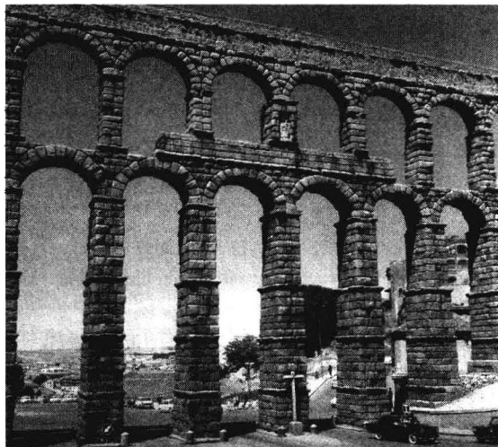
图二十九 罗马拱顶(ROMAN AQUEDUCT)，塞哥维亚(Segovia) 在奥古斯都当政时建成最壮观的拱顶，塞哥维亚拱顶达到最高的高度：28.29 米。(© 艺术资料,纽约)
